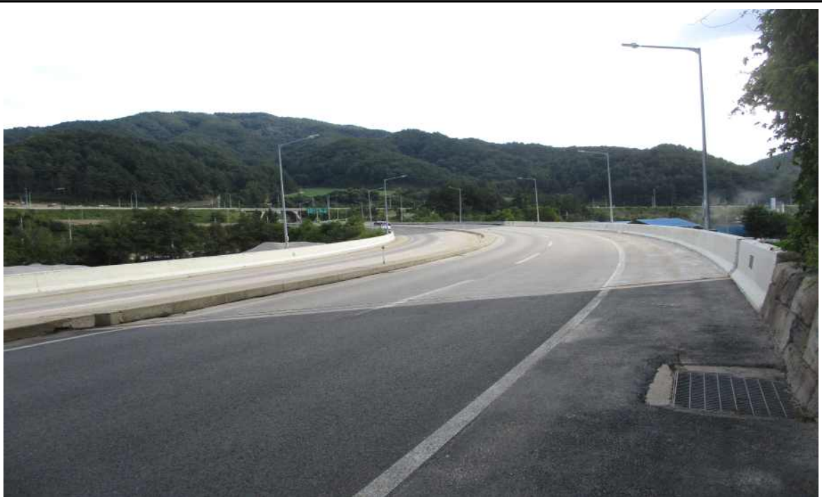
교량 상부 전경
